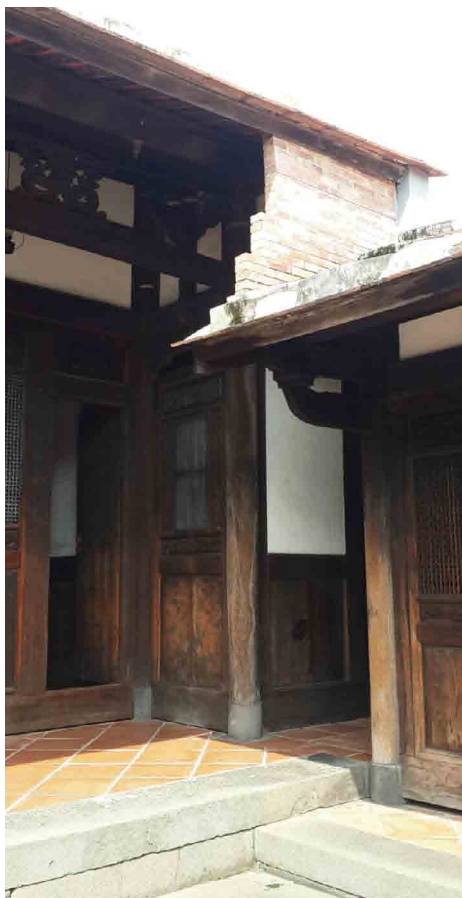
▲第一進與護龍之間的建築空隙處，亦以紅磚圍牆做連結
