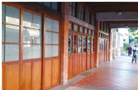
▲剝皮寮建築外觀與廊道
